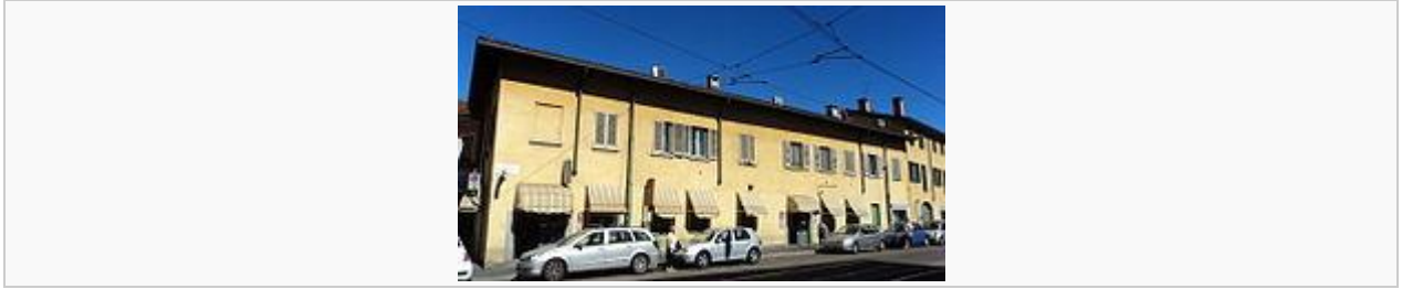
L'antica cascina di via Cinque Maggio, 2 vista lungo via Mambretti
