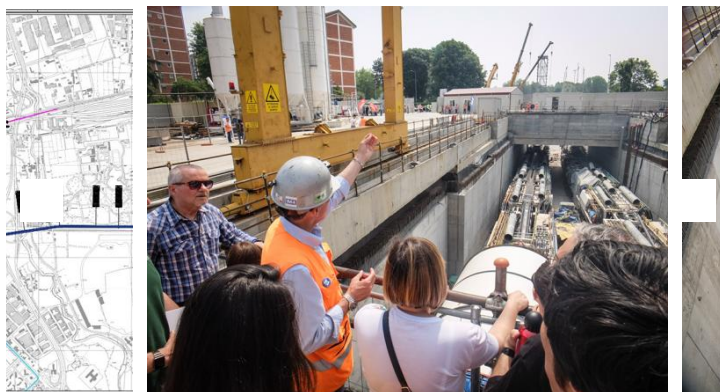
Porte aperte nel cantiere della M4
