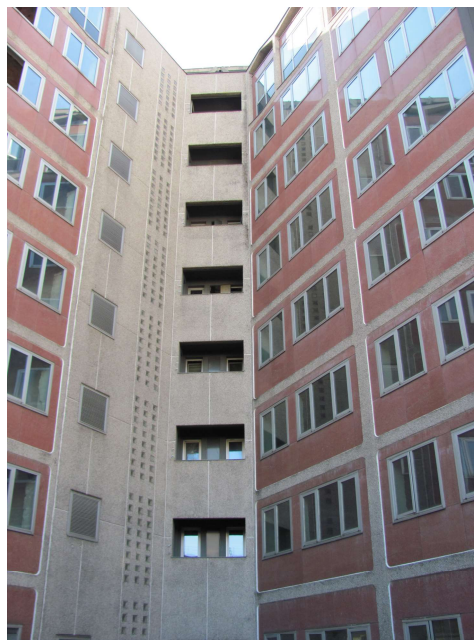
Particolare dell'edificio a Y
