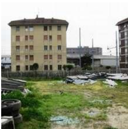
Zona con presenza di amianto
