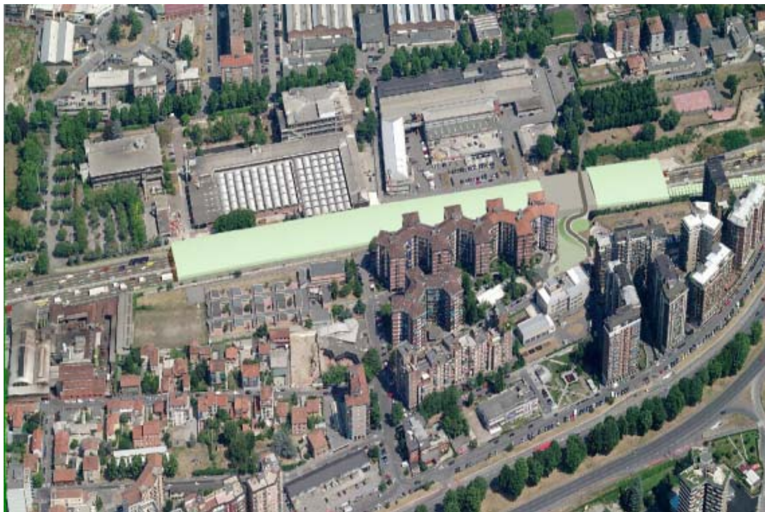
Figura 13: vista aerea da sud della copertura antifonica a (Cinisello Balsamo)
