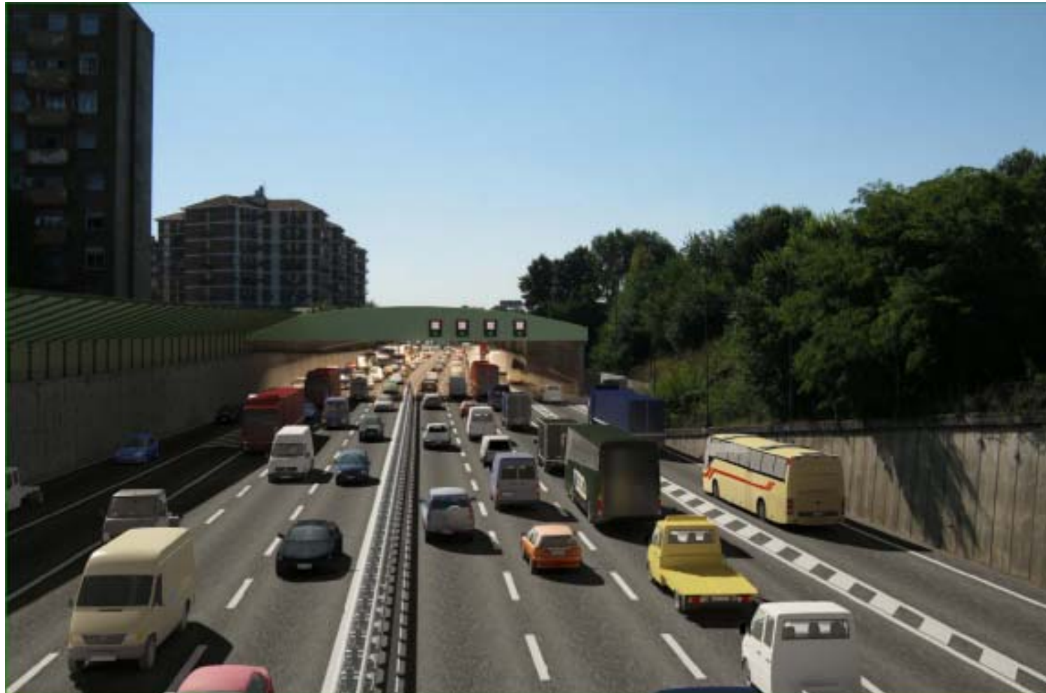
Figura 12: vista dell'imbocco est della copertura antifonica a (Cinisello Balsamo)
