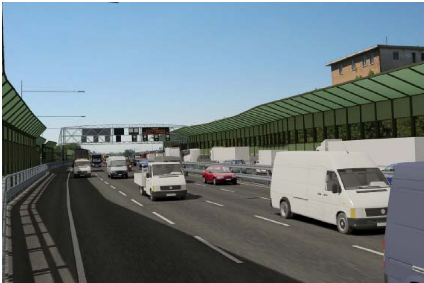
Figura 11: vista dall'interno in zona Balsamo (Cinisello Balsamo)
