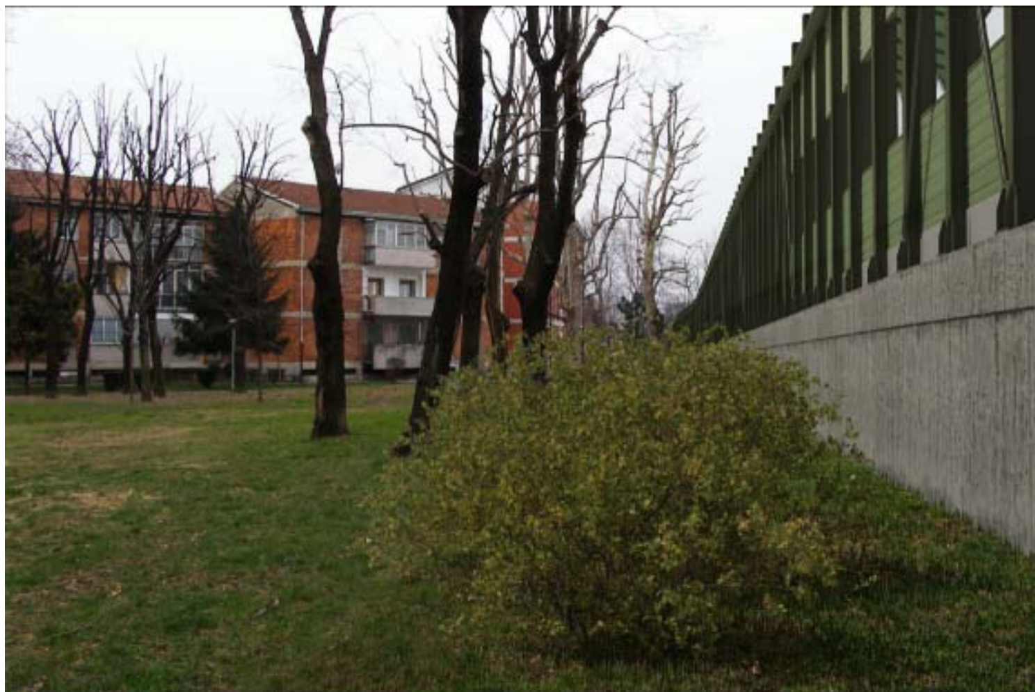
Figura 9: vista dall'esterno in zona Quarto Oggiaro (Milano)
